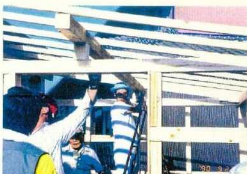
12. 木造部分の工事ほぼ完了
