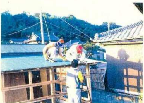
13. 屋根トタン張り
