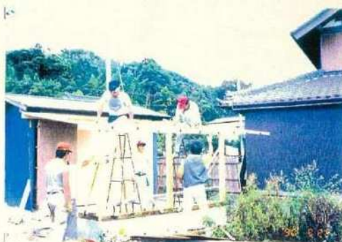
10. 屋根部分の工事にはいる
